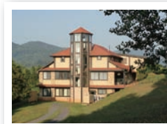
丘の斜面に建てられた施設。ガラス張りの、中央の階段が特徴的。
